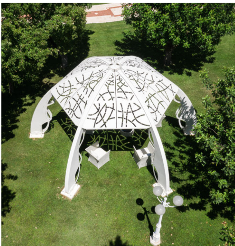
Struttura realizzata per una sala ricevimenti Materiale: acciaio Finitura: verniciato RAL bianco 9010 Anno di produzione: 2018
